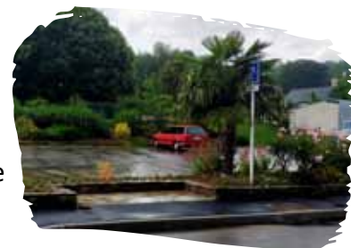
Quai de bus rue de Guerlédan à finaliser
