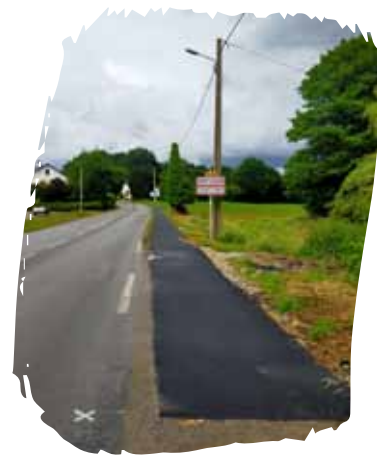
Cheminement piétonnier en cours rue du Blavet
