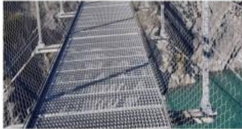
Passerelle de Monteynard
