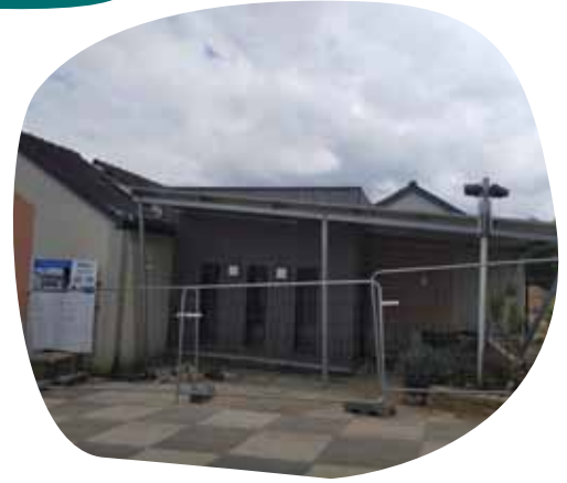
La nouvelle entrée de la salle en cours d'aménagement.
