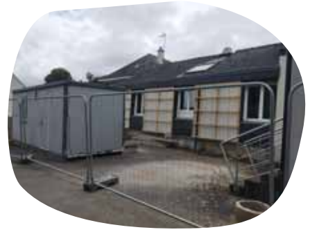
Bardage en bois de la cuisine de la salle René Anès en cours de pose.
