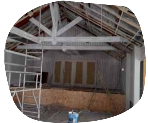
La nouvelle scène est en cours de construction.
