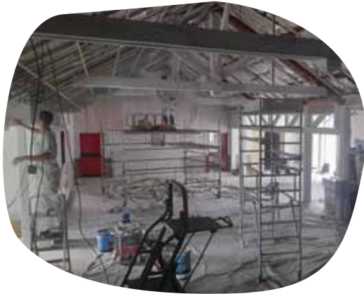
Les peintures sont en cours dans la salle René Anès.
